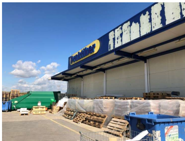
Εξωτερική άποψη του ακινήτου Πίσω όψη κτιρίου
