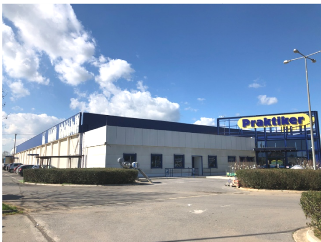
Εξωτερική άποψη του ακινήτου Πρόσωση από την ΕΟ Καλαμάτας-Τρίπολης
